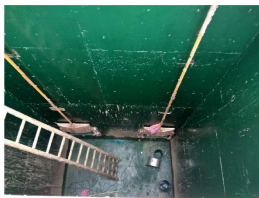
粗格栅防腐防渗
