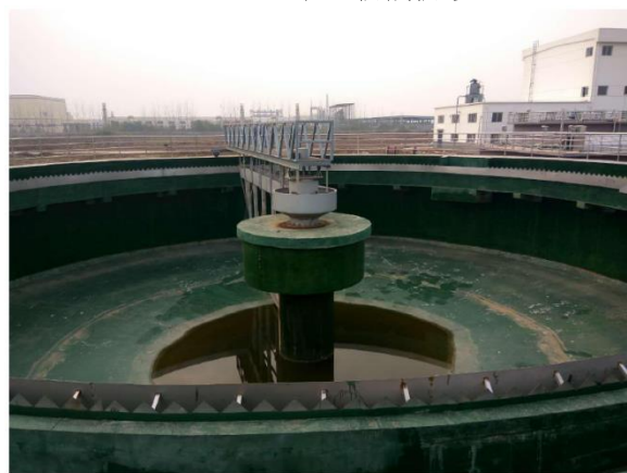
二沉池防腐防渗
