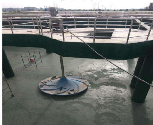
水解酸化池防腐防渗
